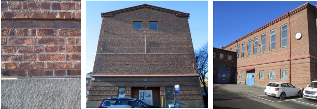
T.v. detalj, den rusticerade bottenvåningen och sockel i gråsten, i mitten; gavelfasad mot norr, fasaden är ombyggd och ingång flyttad efter fotot är taget, bygglov och byggnadsantikvariskt utlåtande har tagits fram. T.h. fasad mot sydost. Foto Sara Holényi.
